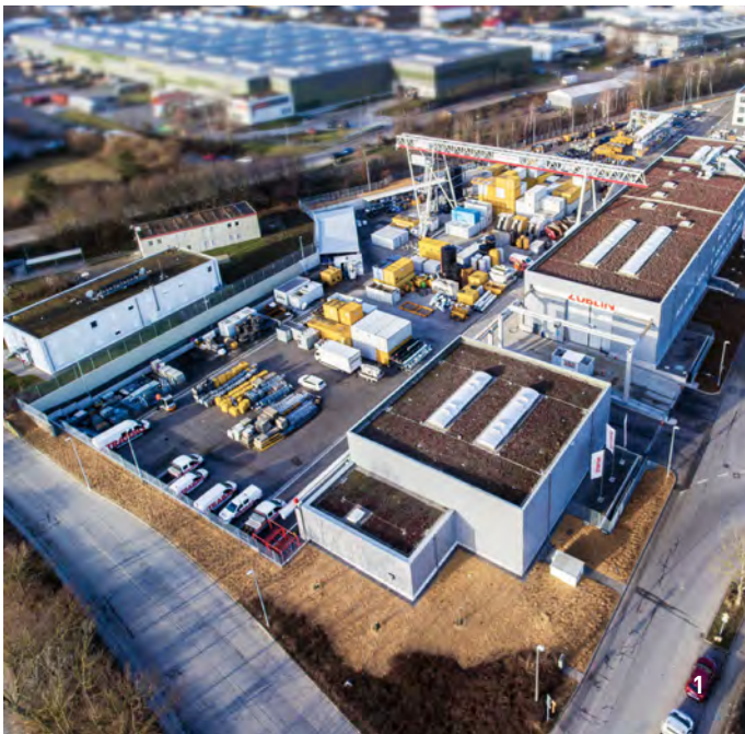
1 sede central, Markgröningen / 2 3D Construcción planta de tratamiento de agua subterránea, Suiza / 3 Taller de reparación y mantenimiento de bombas
