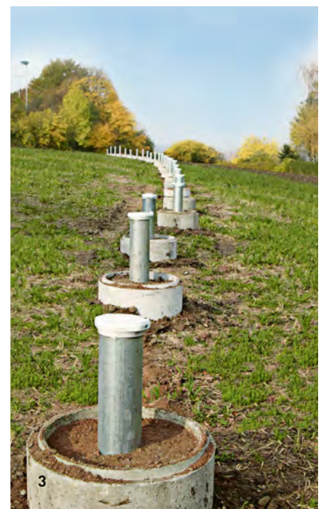
1 | contenedor ISBO, Italia / 2 | contenedor ISBO/ filtro vertical, Alemania / 3 | Puntos suministro de O 2 al agua subterránea, Alemania
