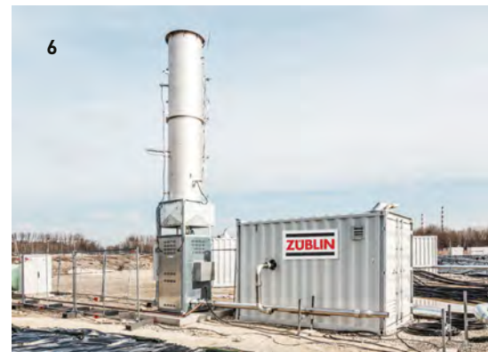
1 filtro de aire con carbón activo, regenerable por vapor, Berlín / 2 Filtro de aire con carbón activo, Suiza / 3 oxidación catalítica, Alemania / 4 Medición del aire residual con cromatografía de gases, Suiza / 5 postcombustión regenerativa, Alemania / 6 Postcombustión térmica/horno de alta temperatura, Alemania/
