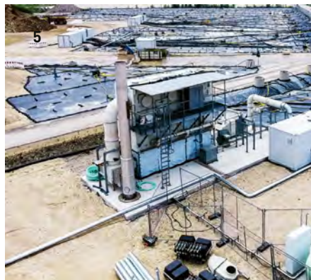
1 filtro de aire con carbón activo, regenerable por vapor, Berlín / 2 Filtro de aire con carbón activo, Suiza / 3 oxidación catalítica, Alemania / 4 Medición del aire residual con cromatografía de gases, Suiza / 5 postcombustión regenerativa, Alemania / 6 Postcombustión térmica/horno de alta temperatura, Alemania/
