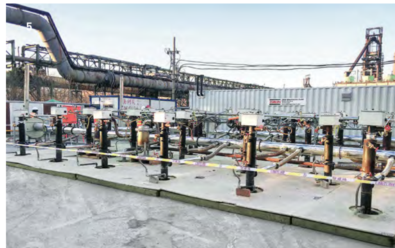
3 ISTH, lanzas térmicas accionadas eléctricamente, Suiza © SBB OFF FFS / 4 ISTH, inyección de vapor y aire, Alemania / 5 ISTH, lanzas térmicas accionadas por gas, China
