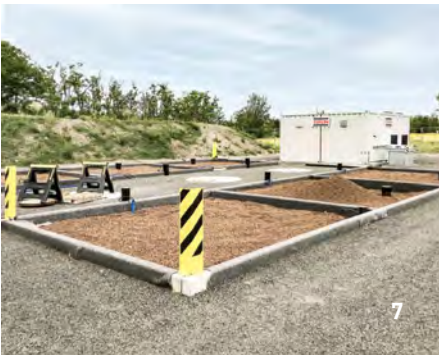
7 humedal, filtro de suelo de flujo vertical, Alemania/ 8 Reducción química in situ con nano- y micro-hierro, © Anke Wiener/ 9 Extracción multifásica, Italia/ 10 Skimmer para extracción de fases, Austria
